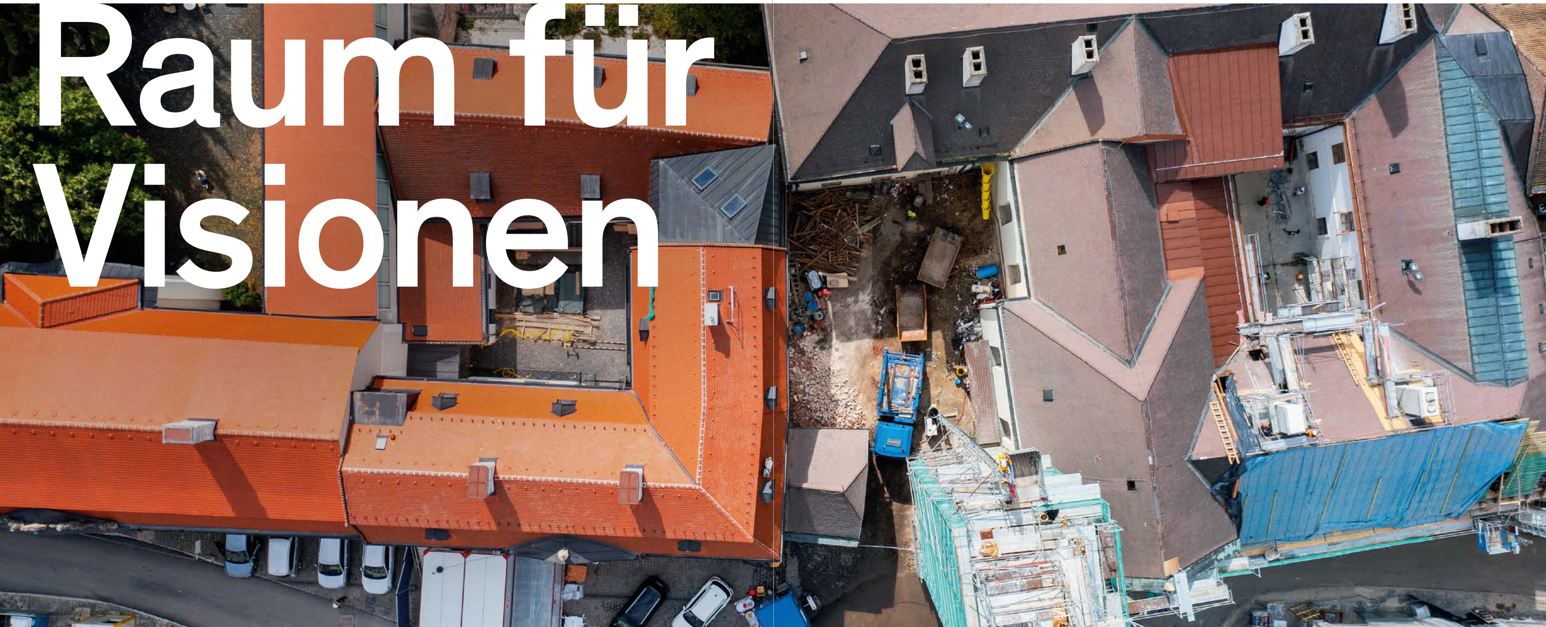
Burg-Rekonstruktion Veszprém, Ungarn
