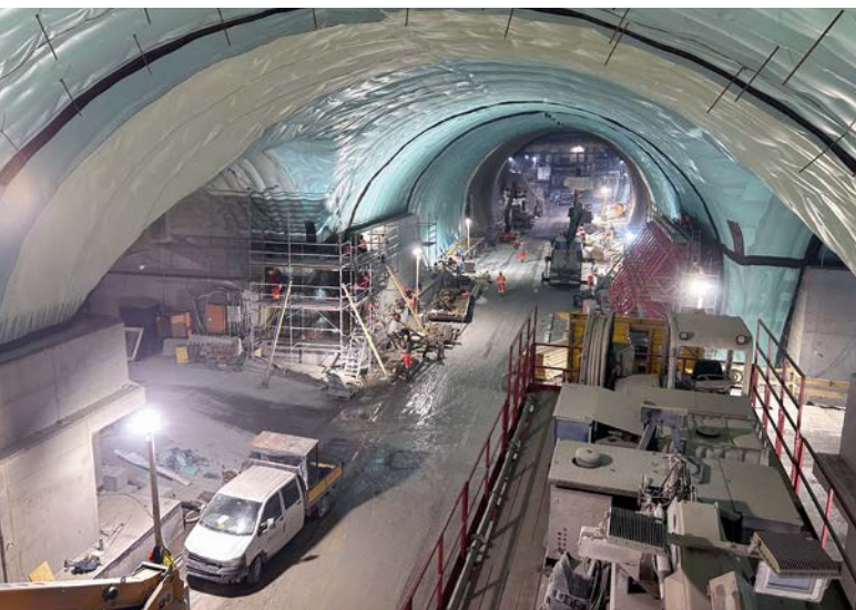
Basistunnel Semmering, Steinhaus am Semmering, Österreich
