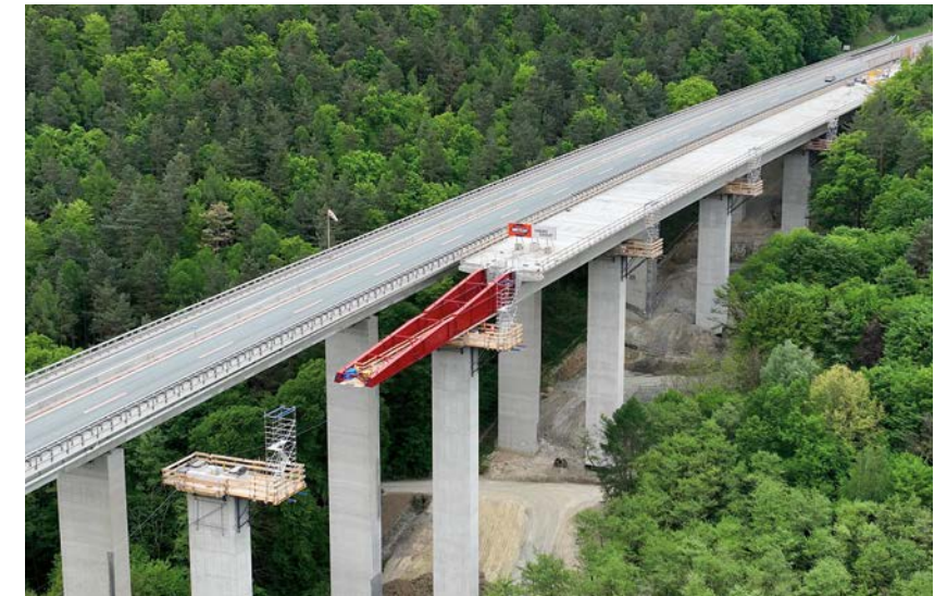
ARGE Talübergänge S31, Siegraben, Österreich
