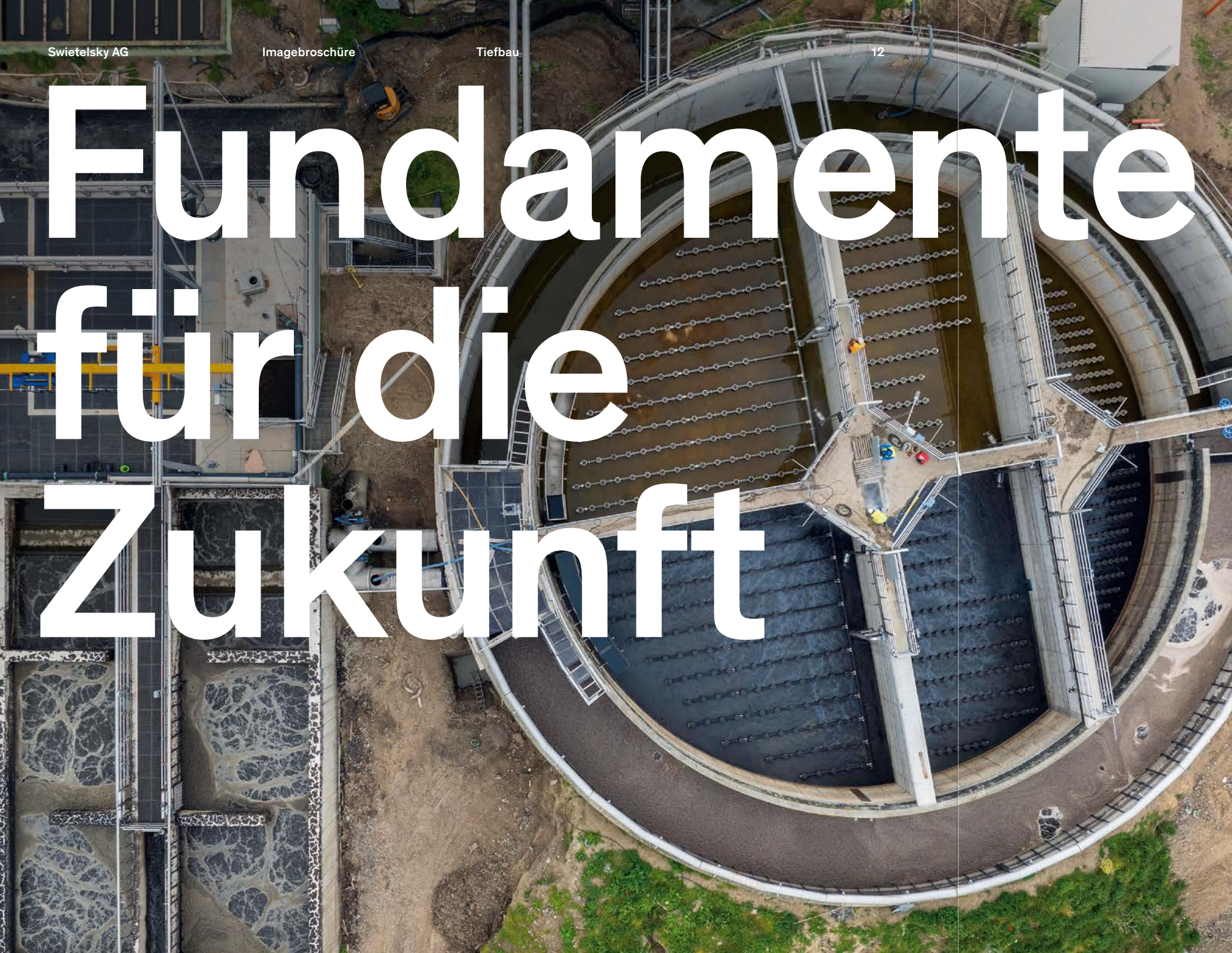
Kläranlage Cegléd, Ungarn ↑
