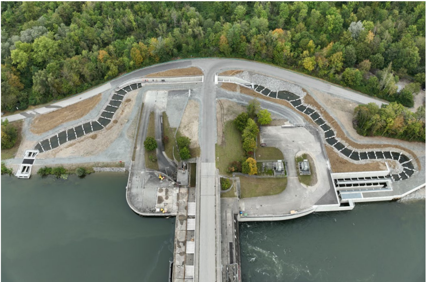
Fischaufstiegsanlage, Landau ad Isar, Deutschland
