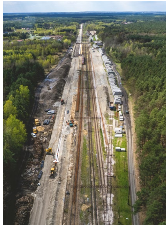
Streckensanierung Stalowa Wola – Tarnobrzeg – Sandomierz – Ocice, Polen
