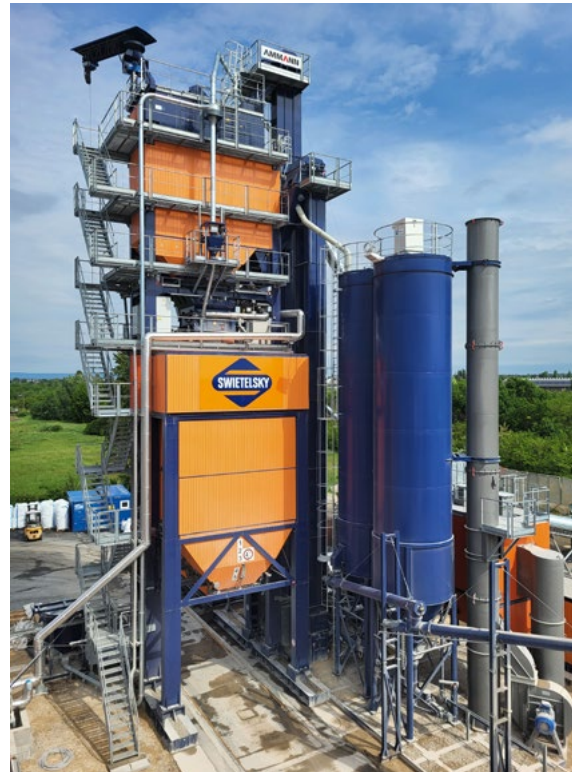
Asphaltmischanlage, Székesfehérvár, Ungarn
