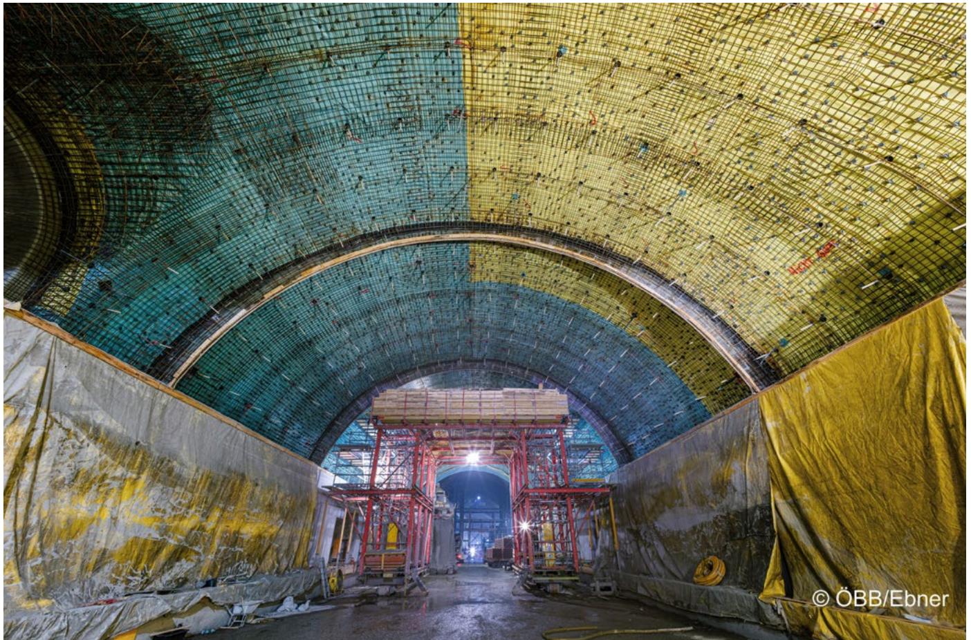
Nothaltestelle, Semmering Basistunnel, Österreich
