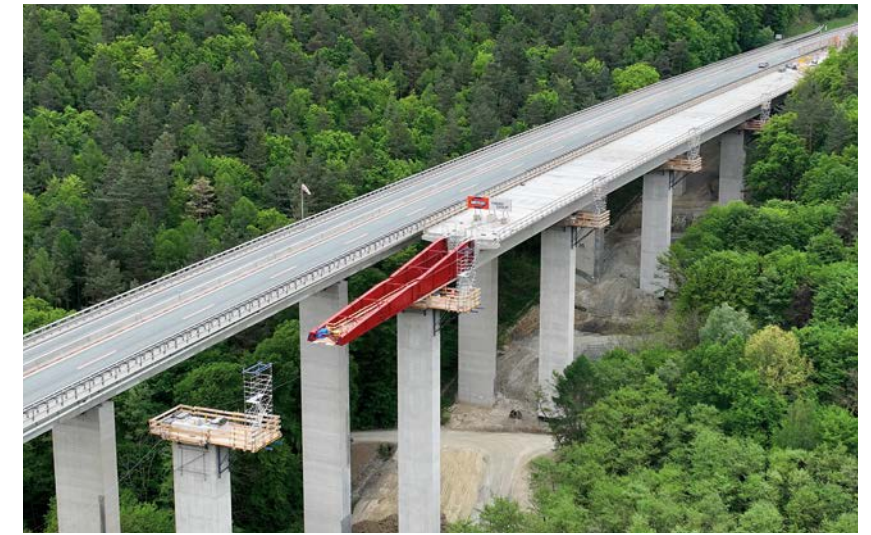
ARGE Talübergänge S31, Sieggraben, Austria
