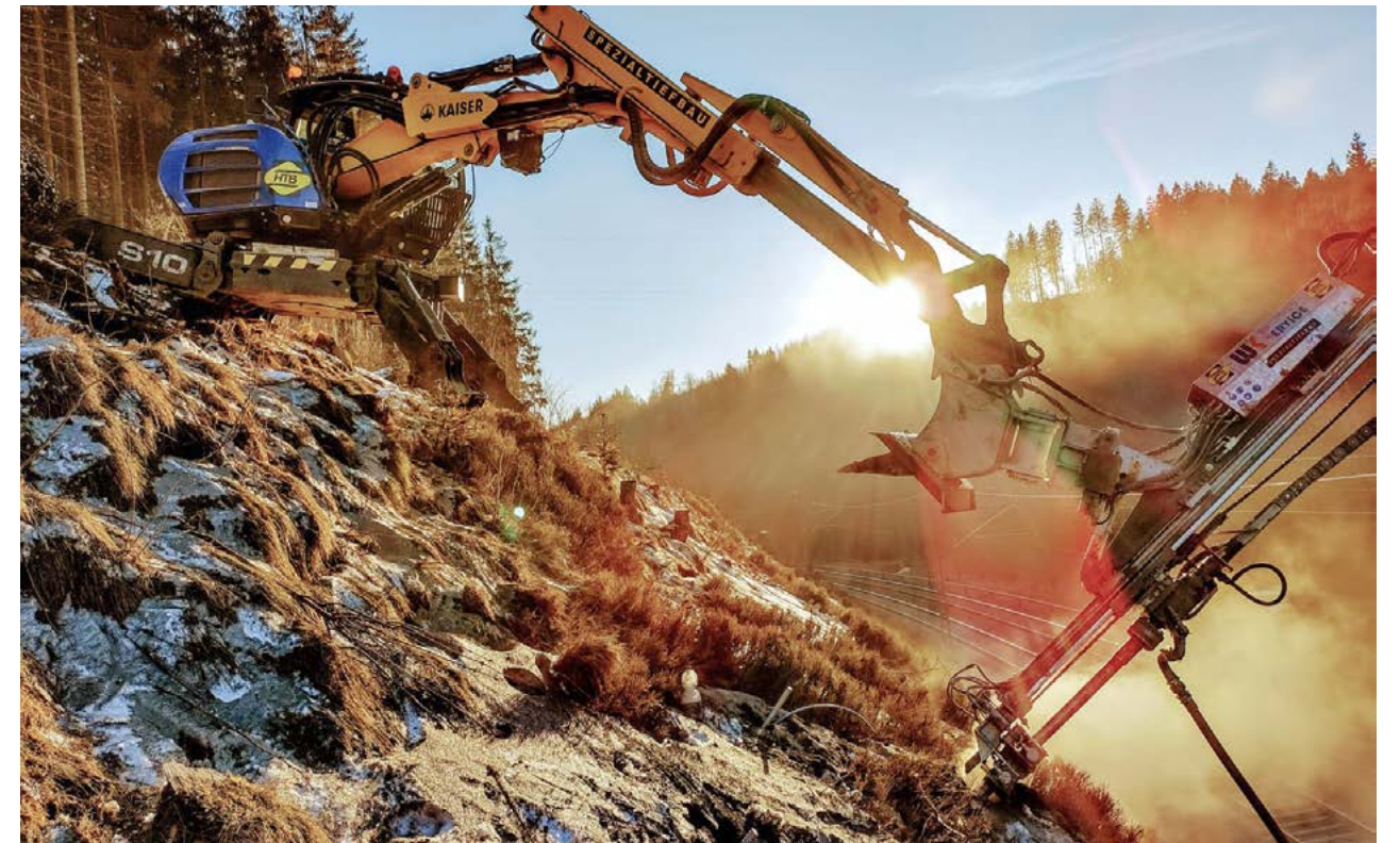
Felssicherungsarbeiten, Steinbach am Wald, Deutschland
